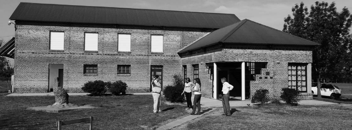
Das Haupt- ▲ gebäude des Tageszentrums für Kinder in Urdinarrain
