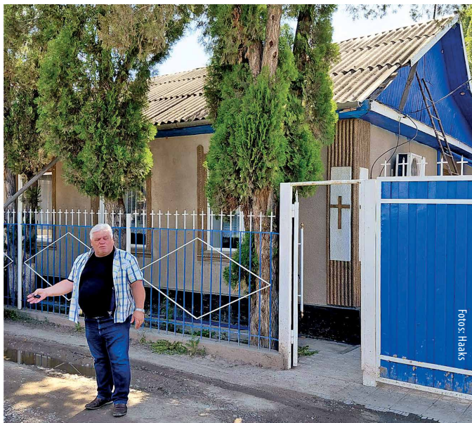
Mit dem Projektkatalog 2025 hat das GAW die Sanierung des Bethauses in Winogradnoje unterstützt. Vor dem Haus steht Bischof Alfred Eichholz.
