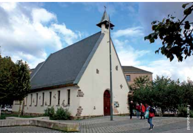
Das GAW hat die Sanierung der Versöhnungskapelle 2020 und 2025 unterstützt.
