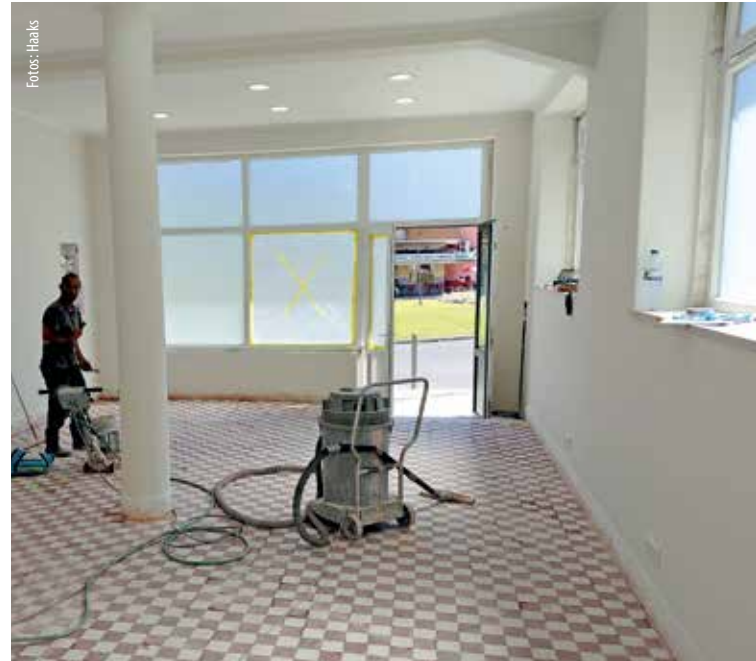
In Damaia entsteht mit Hilfe des GAW in den früheren Gemeinderäumen ein Sozialzentrum.
