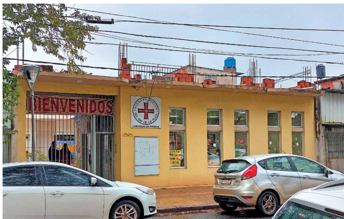
In Posadas hat die Erweiterung des Gemeindezentrums begonnen, dessen Renovierung das GAW unterstützte.
