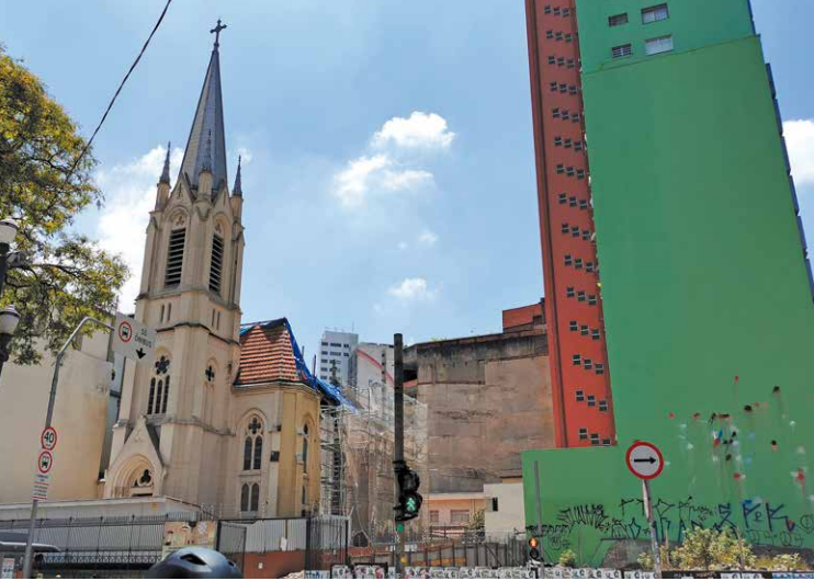
Der Turm und der Chorraum der Lutherkirche stehen noch. Dort, wo das Kirchenschiff war, klafft ein Loch.
